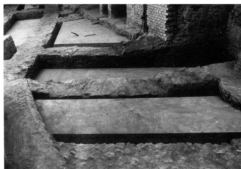
Fig. 6. Le fondazioni in corso di scavo
