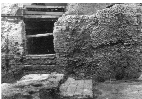
Fig. 5. Vista del prospetto esterno in corso di scavo
